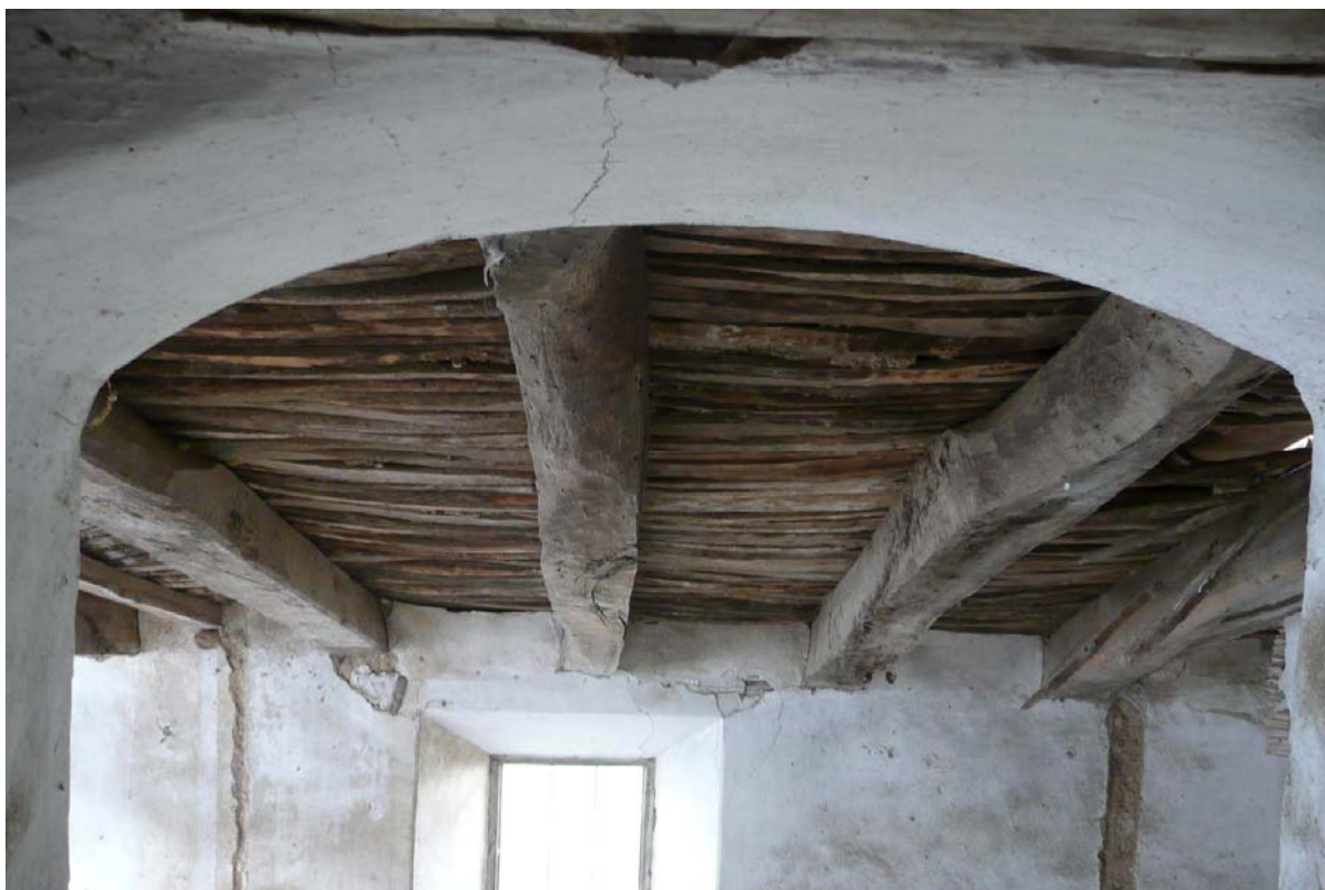
Foto 29. Entresuelo con jácenas es cuadradas con hachuela y entrevigados de tiguillos.
