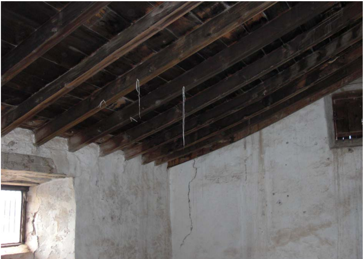
Foto 26. Faldón a la molinera con pares escuadrados y entrevigados de tabla.
