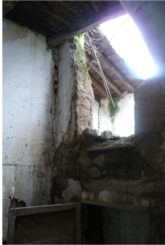
Fotos 18 y 19. Cuerpo norte de cocinas. Muro exterior y cubierta parcialmente arruinados.
