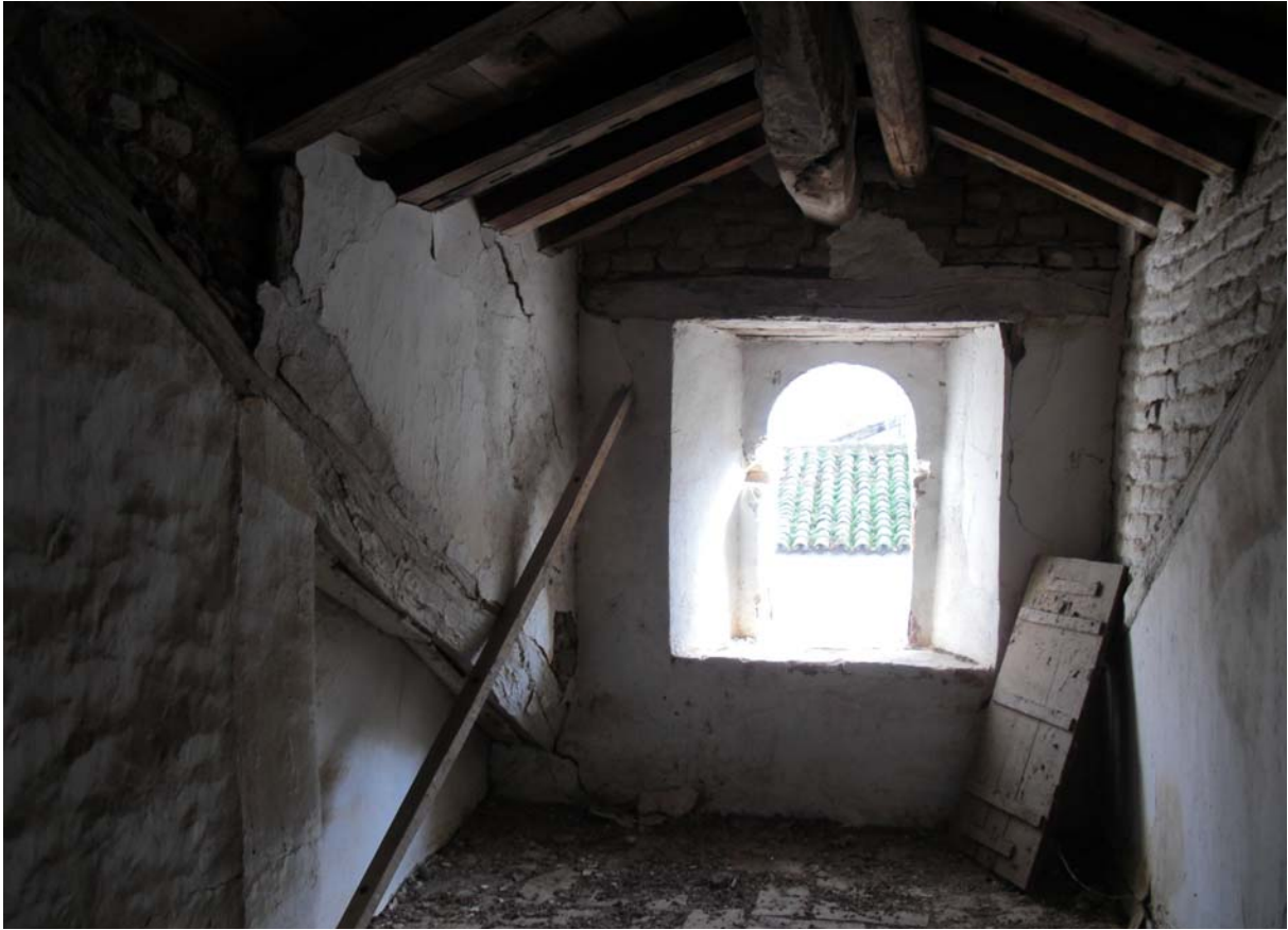
Foto 23. Buhardilla a segundo patio.
