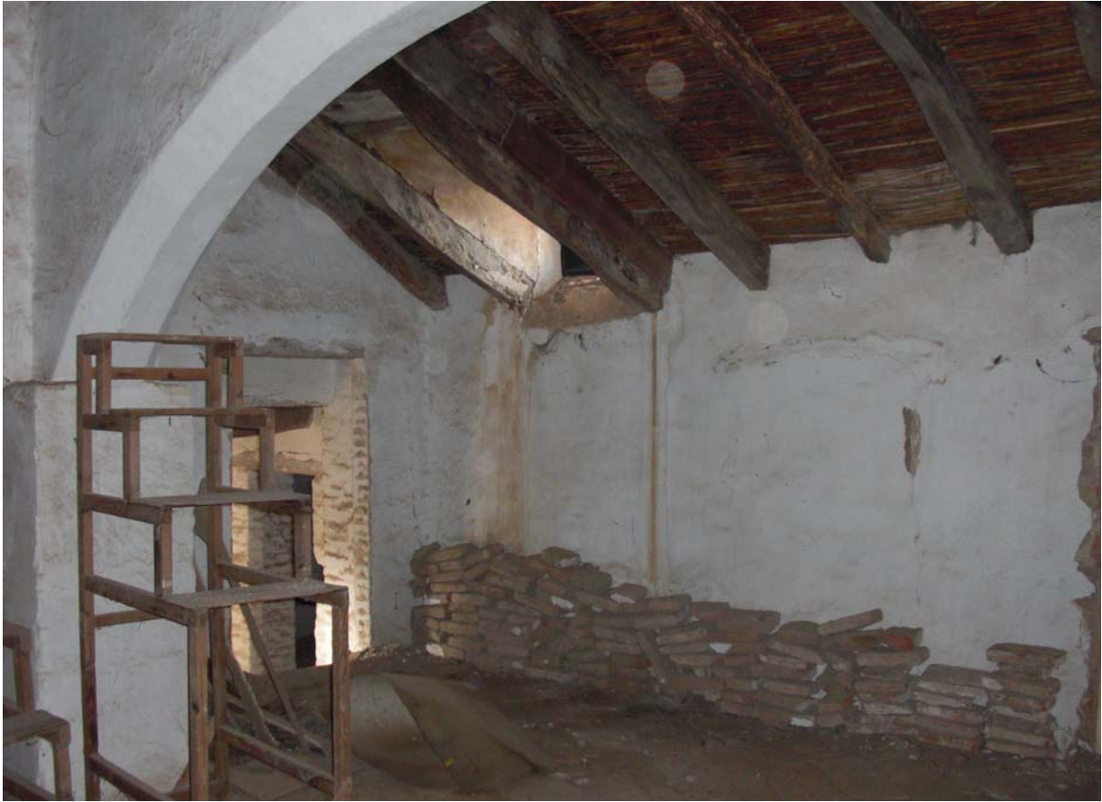
Foto 27. Salón de planta primera en segunda crujía a patio del aljibe.
