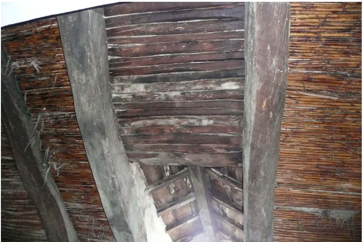
Foto 28. Faldón con buhardilla. Entrepaños con cañas y restos de tiguillos.
