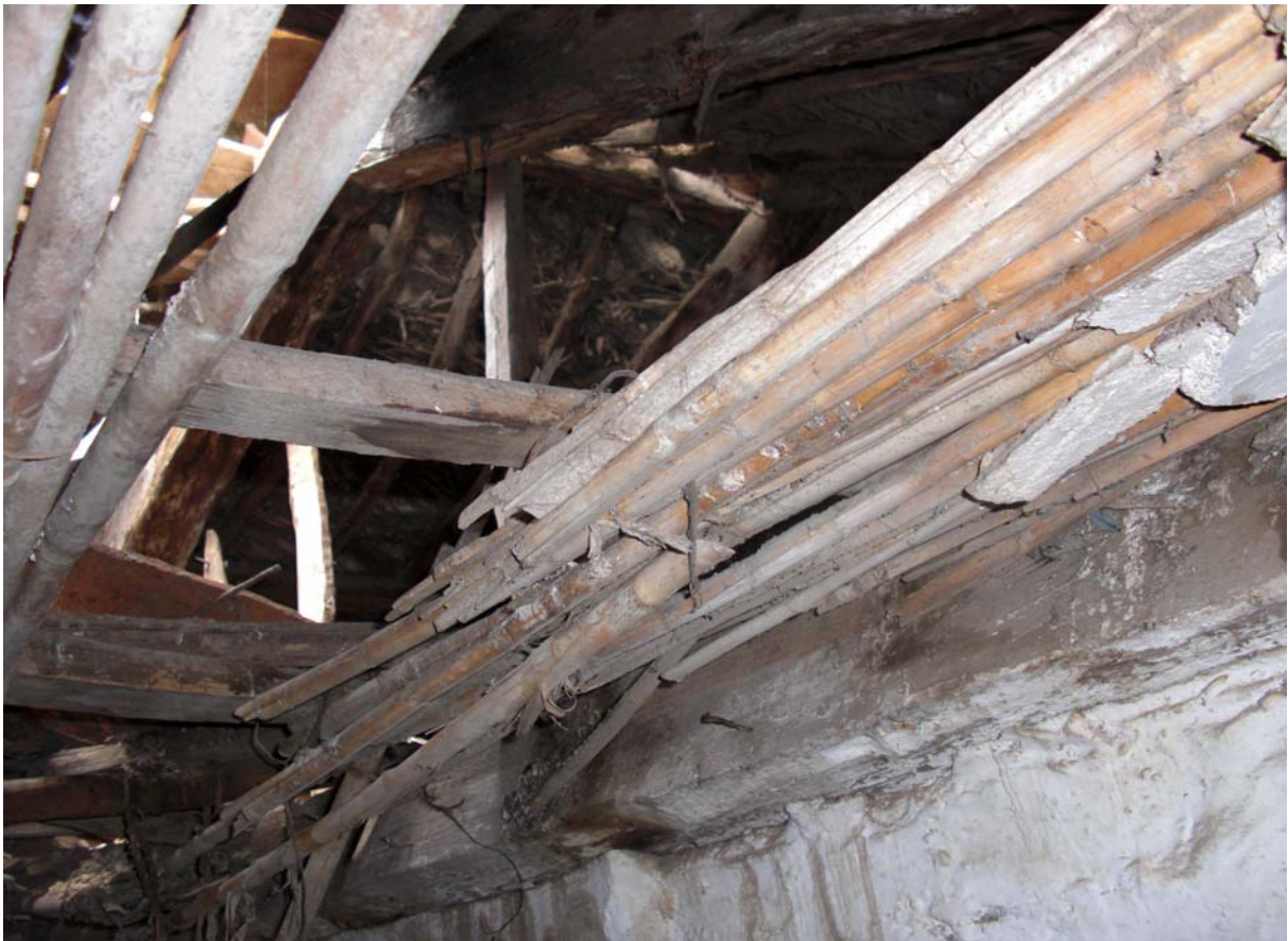
Foto 24. Falso techo de caña. Deja vista la cubierta superior con tiguillos de ramaje.
