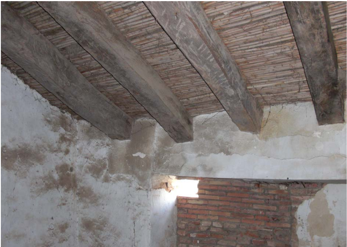
Foto 22. Entrevigado de caña sobre vigas escuadradas.
