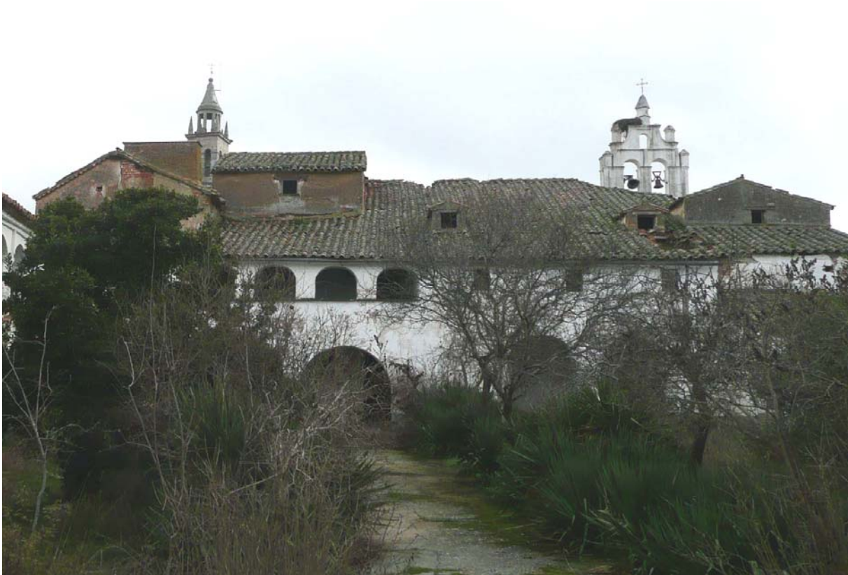
Foto 7. Cuerpo trasero desde el tercer patio. Vista de las cubiertas a reparar.
