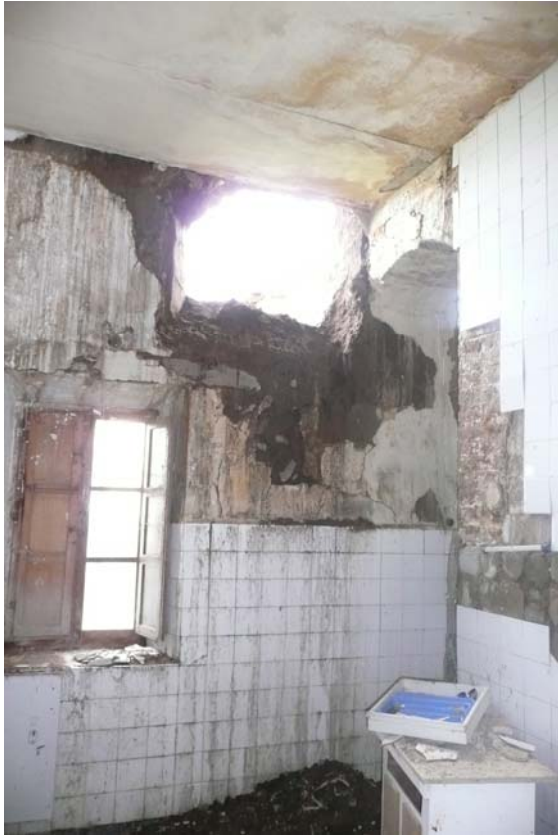
Fotos 18 y 19. Cuerpo norte de cocinas. Muro exterior y cubierta parcialmente arruinados.
