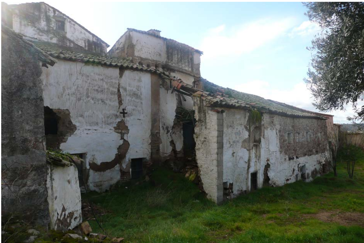
Foto 17. Cuerpo de cocinas al norte. Vista exterior.
