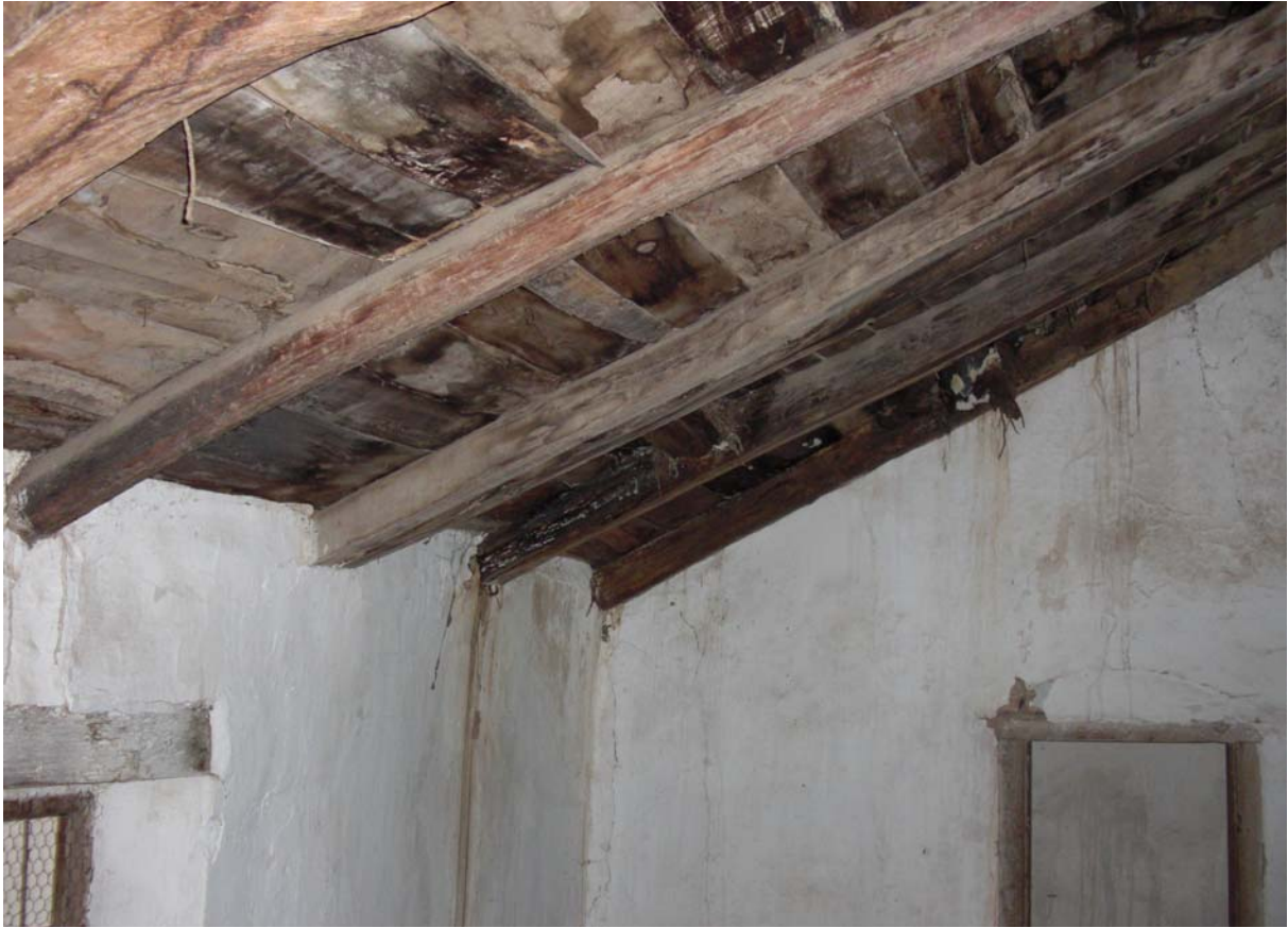
Foto 25. Faldón a la molinera con entrevigado de tabla sobre pares de rollizos.
