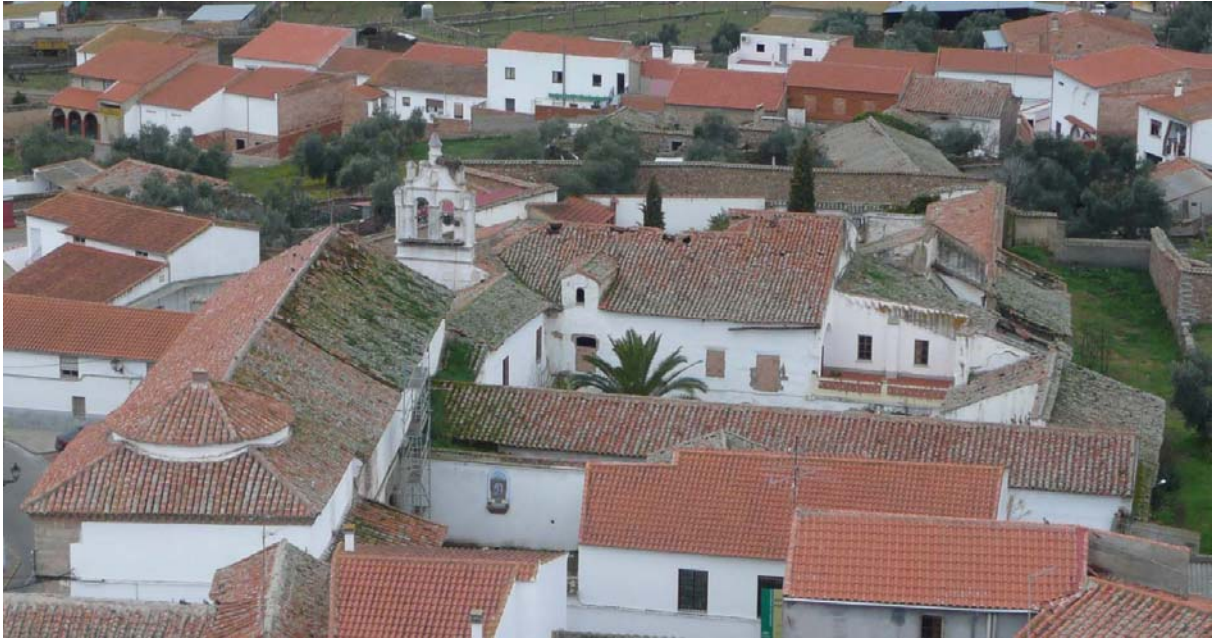
Foto 4. Vista del conjunto de cubiertas del Convento.
