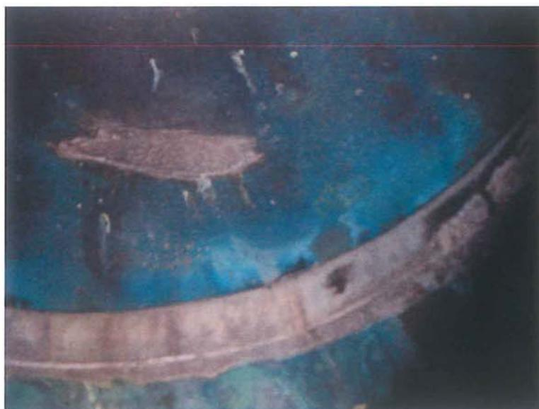
Figura II.5. Interior de una de la manzana nº. Se puede observar la cinta metálica que une las dos semiesferas.
